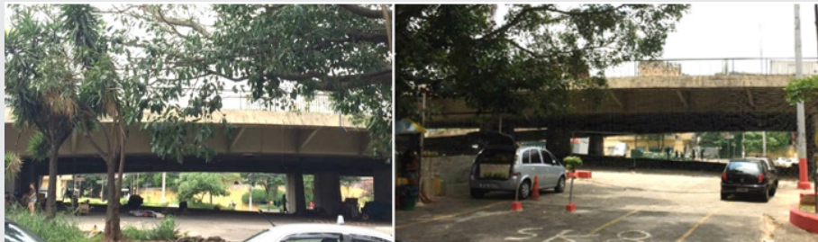
Figuras 3 e 4: Baixos do Viaduto Julio Mesquita Filho em dois momentos em 2018: em fevereiro ocupado por pessoas em situação de rua e em dezembro, com parte da estrutura da Arena Bela Vista. Após um acordo com os sem-teto para que se alocassem em outros trechos do viaduto, instalou-se o projeto com doações da própria vizinhança. Fonte: Autores, 2018.
