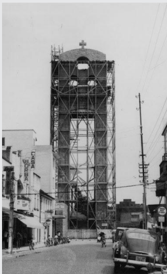
Figura 7: Perspectiva da Rua XV de Novembro, em torno de 1960, com o campanário da “nova” Igreja Matriz, virtualmente recuperando a posição da antiga torre. Fonte: Arquivo Histórico José Ferreira da Silva.
