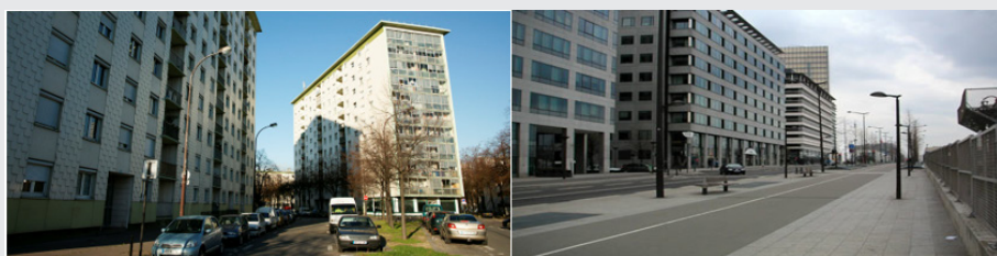
Figura 13: Visão interna de área já implantada do Projeto. Fonte: APO, 2012
