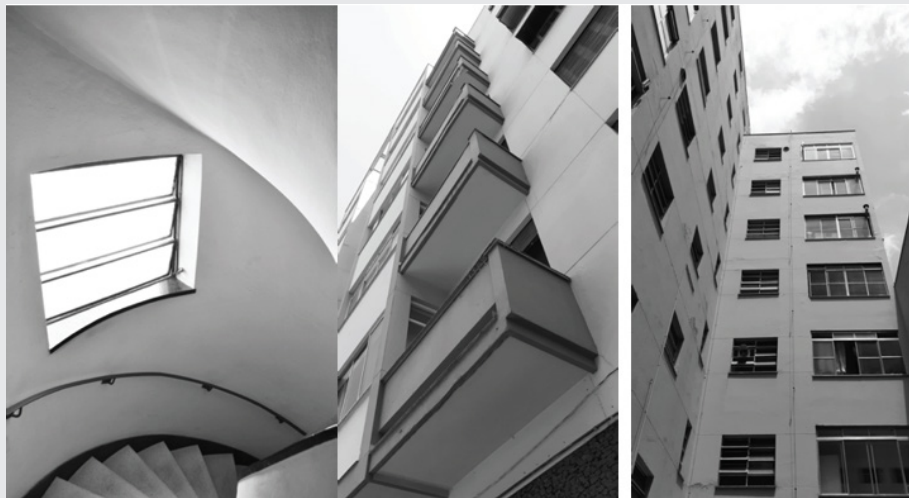
Figura 6, 7 e 8 : Edifício J. B. Ferreira Lopes. Construído em 1953 pela Construtora Miro, Arq. Mirosław Szabuniewicz.
