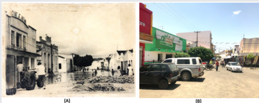
Figura 8: Cine São João. Fonte: Acervo do fotógrafo Toinho Dutra, 1970 (A); Acervo dos autores, 2019 (B).
